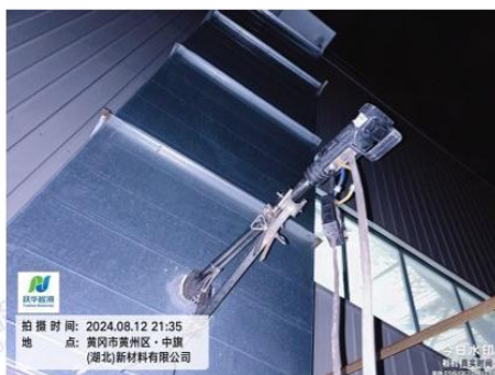
DA008 混料废气排气筒 2@YQ7
