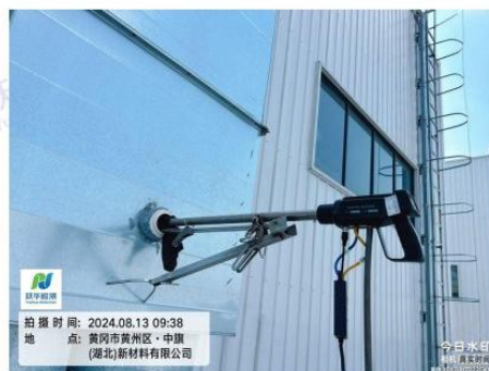
DA009 混料废气排气筒 3@YQ8
