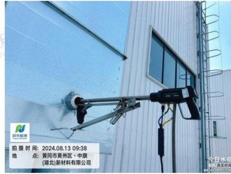
DA009 混料废气排气筒 3@YQ8
