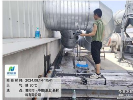
DA003 有机废气排气筒进口①YQ4
