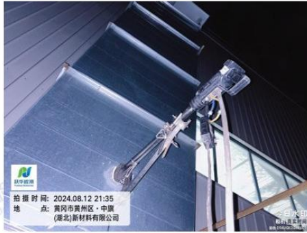
DA008 混料废气排气筒 2@YQ7
